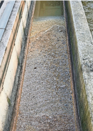
Das im Abwasser entsorgte Fett schwimmt an der Oberfläche und wird im Fettfangbecken abgezogen. Mit dem Schlamm aus dem Vorklärbecken gelangt es in die Faulung. Foto: Sven Heiling/Abwasserzweckverband
